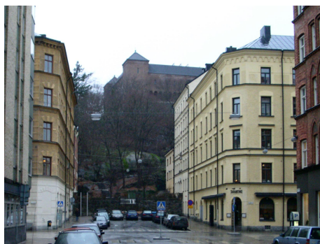
Fig. 1. Ingemarsgatan sedd mot väster (Vanadislunden). I fonden kv. Blåkråkan till höger och kv. Vilan till vänster.
